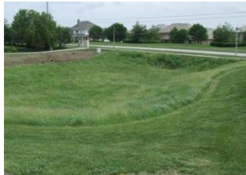
Infiltración de agua lluvia
